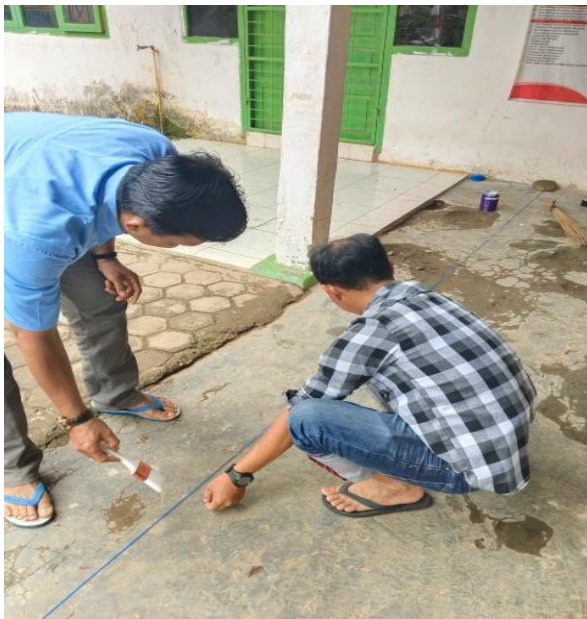
Gambar 1.3 : pengukuran tempat pembuatan marka
