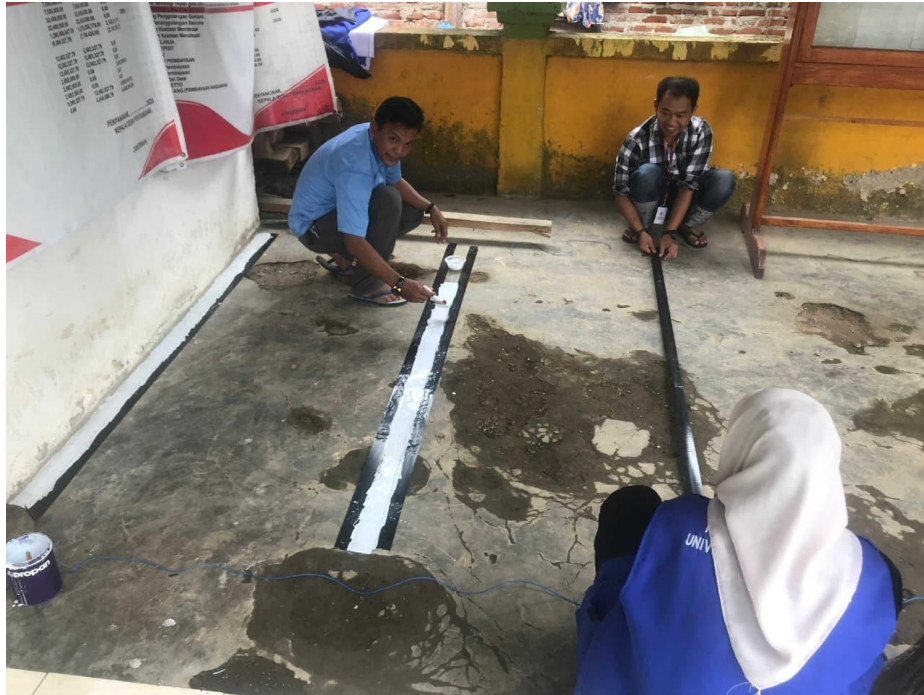
Gambar 1.4 : pengecatan marka parkir
