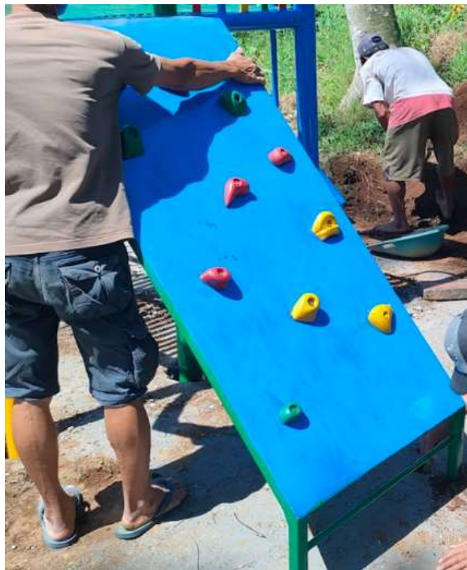
Gambar 3. Pemasangan dan pengujian wahana bermain rintang panjat tali
