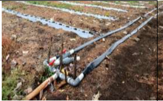
Gambar 12. Instalasi jaringan irigasi tetes
