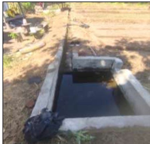
Gambar 10. Bangunan Saluran Irigasi yang menghubungkan outlet sumur pompa ke kolam penampungan
